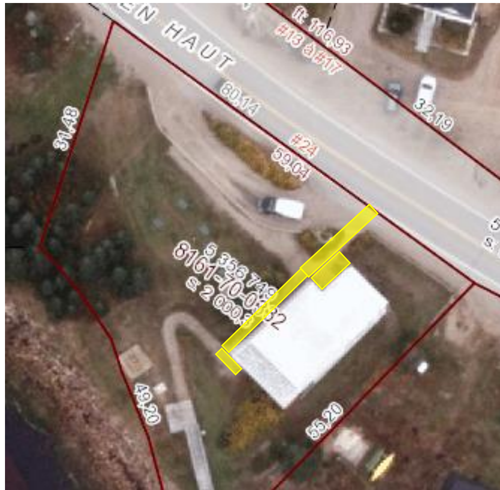
Bâtiment vu de haut :
